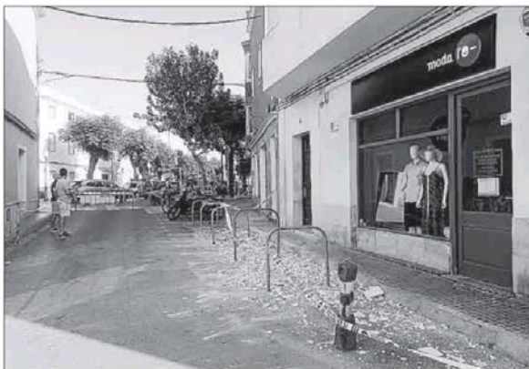
Las baldosas inundaron la acera al pie del edificio. Foto. JOSEP BAGUR
