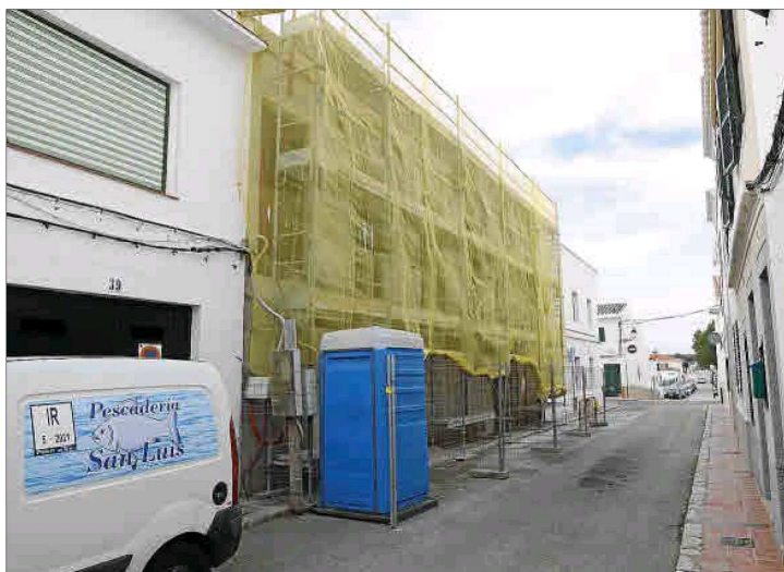
La promoción de cuatro viviendas protegidas en Sant Lluís todavía no está terminada. Foto: JAVIER COLL
