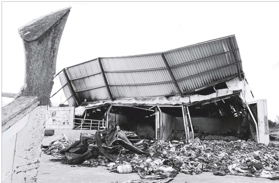
Las ruinas de la planta serán demolidas por Caritas a partir de un proyecto que ya está redactando. Foto: GEMMA ANDREU
