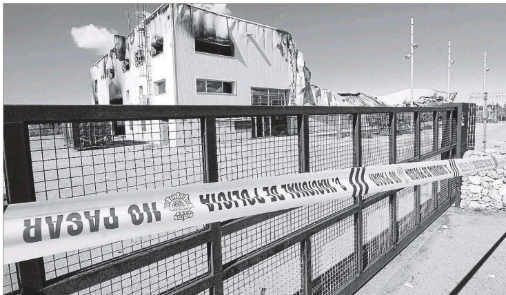
Planta TIV. Continúa precintada por la Policía Nacional lo que impide a la propiedad, bomberos y aseguradora acceder al recinto e iniciar la retirada de escombros. ● FOTO GEMMA ANDREU
