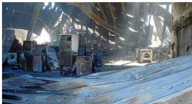
**Imagen interior de la planta incendiada donde se advierten electrodomésticos y parte de la cubierta del techo desplomada**
